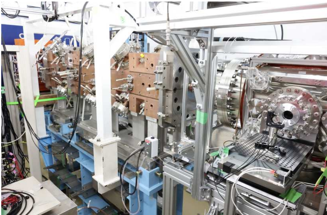
写真1 J-PARC 物質・生命科学実験施設 (MLF) ミュオン実験施設で行われたミュオン冷却・加速の実験装置。正ミュオンビームが右側から入射し、写真右手前の装置で冷却され、その左側にある高周波加速空洞で加速される。加速空洞の左奥に加速されたビームの診断装置が設置されている。
