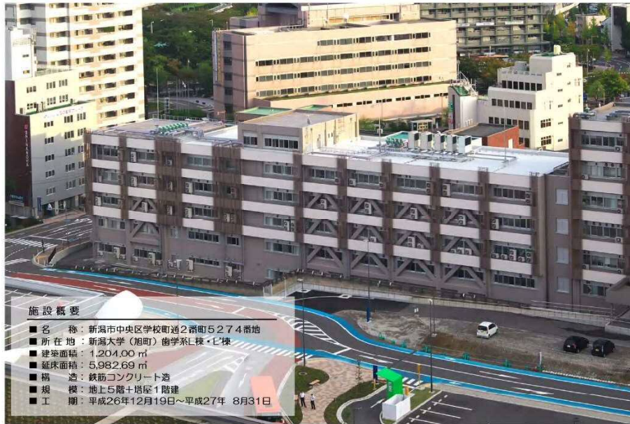
建物 外観（耐震改修に外付補強工法を採用）
