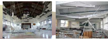
天井材や照明器具の落下 「東日本最大震災をふまえた学校施設の整備について」緊急提言（文部科学省）
