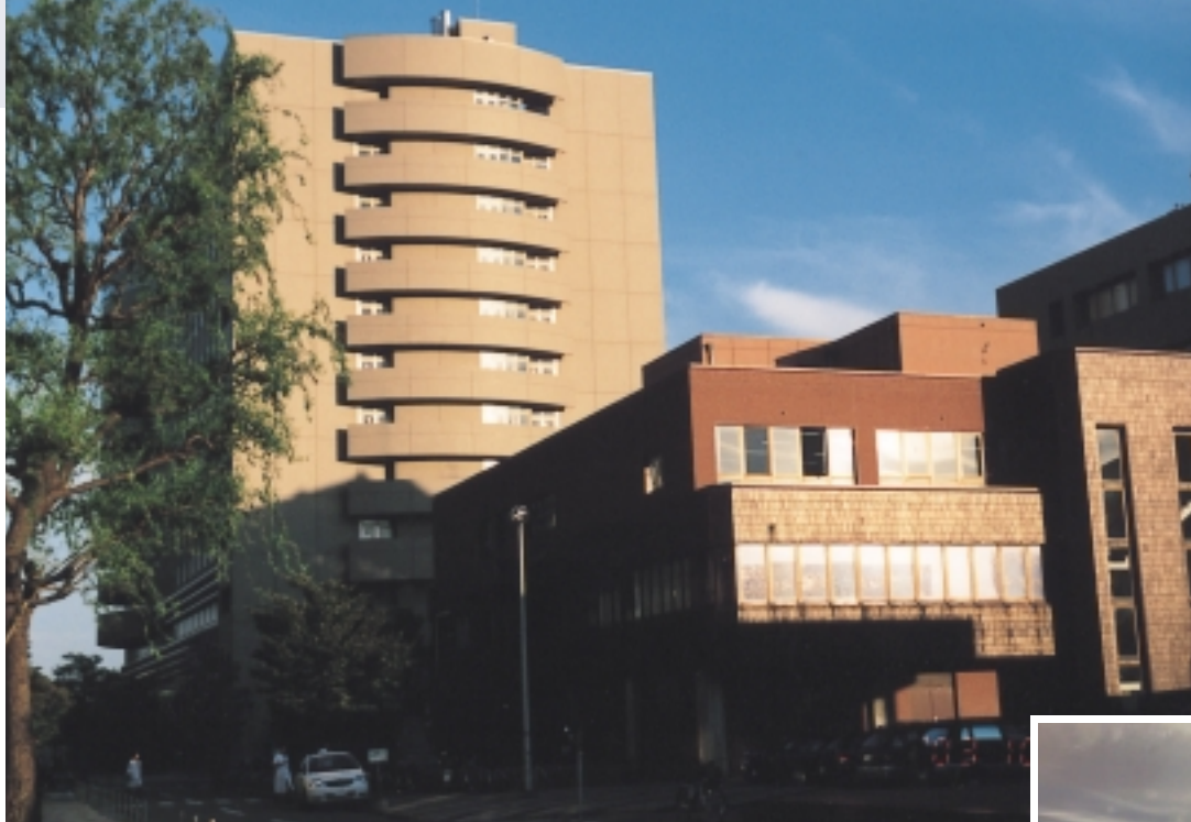
第一期工事で完成した病棟
